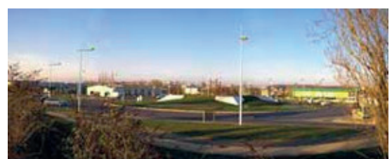
Vue générale du giratoire de Brébonzac
