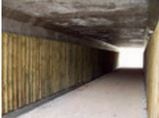
Vue de l'intérieur du passage souterrain du Bois des Geais
