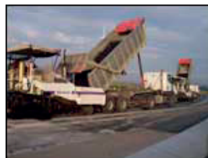
Travaux sur la chaussée Nord
