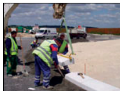
Travaux sur le giratoire
