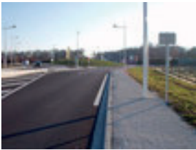
Arrivée sur le giratoire de Recoux depuis Magnac-sur-Touvre
