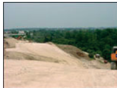
Travaux de terrassement
