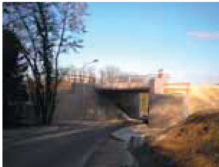
Pont de la route d'Antornac
