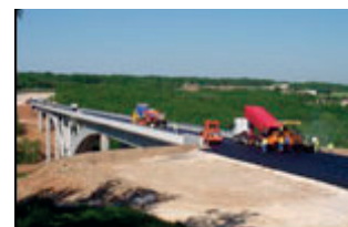
Travaux de chaussée
