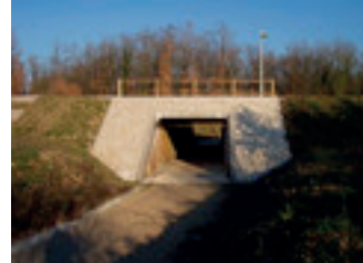
Entrée Ouest du passage souterrain du Bois des Geais
