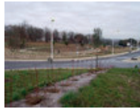
Vue sur bassin depuis rond-point central du giratoire de Recoux
