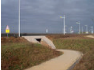
Entrée Est du passage souterrain du Bois des Geais
