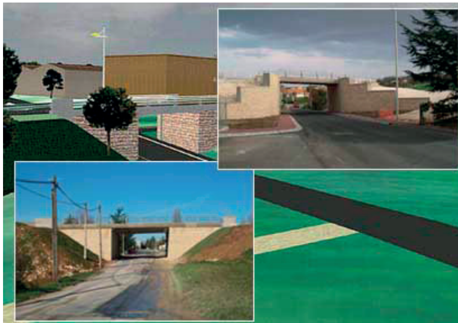
Simulation 3D et photos après travaux
