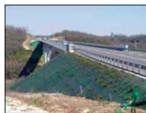
Vue du viaduc
