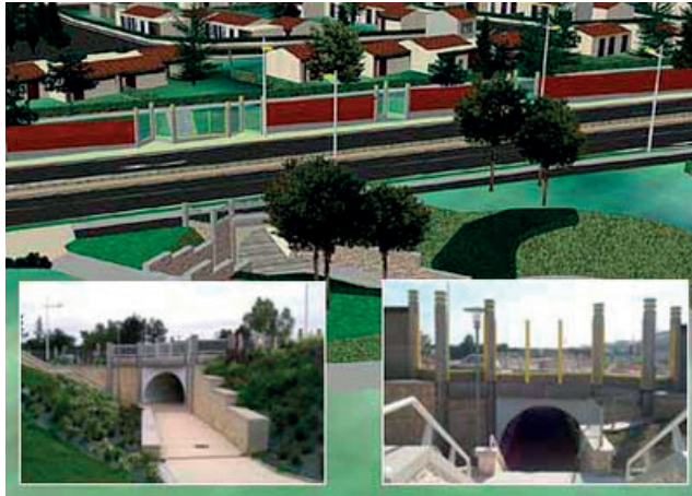
Simulation en 3D et photos des réalisations après travaux
