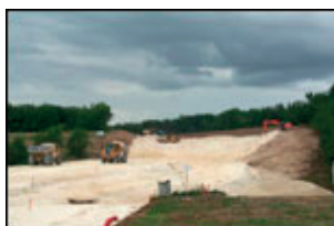
Travaux de terrassement
